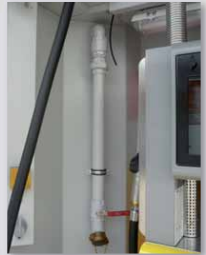
Tankwagen-Befüllanschluss
