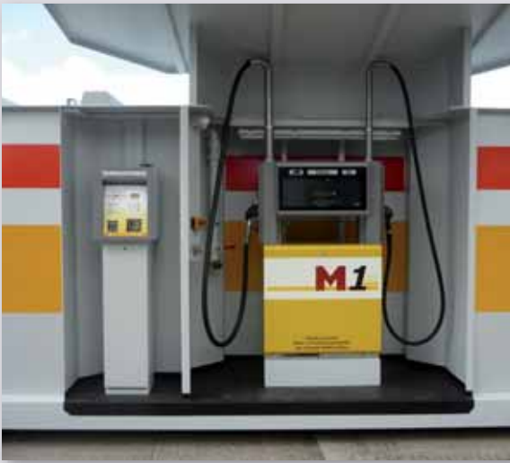
Zapfnische mit Zapfsäule Gilbarco 130 / 40 Liter/min.
