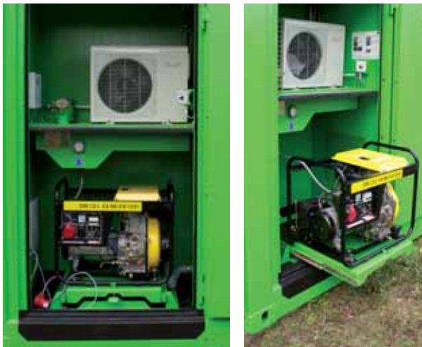
Option: Diesellaggregat zur Eigenstromversorgung, einfache und bequeme Wartung durch herausziehbare Plattform
