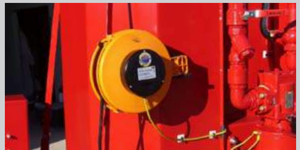
E) Potentialausgleich mit Kabeltrommel und Stecker
