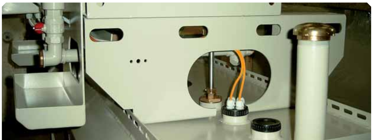
AE-100-E Niveaustandgeber in Ölversorgungsanlage
