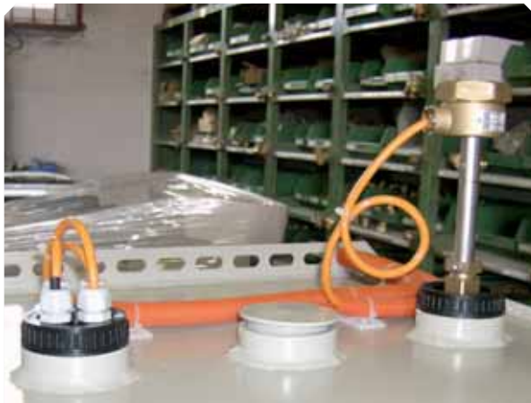
AE-100-E Niveaustandgeber (li.) und Überfüllsicherung (re.)
